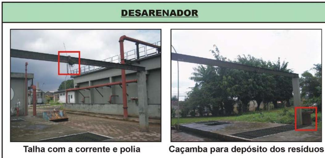
Figura 12 – Detalhes da talha de auxílio para limpeza do desarenador - ETE Sideral .
