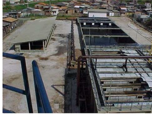
Fotografia 2 – Vista geral: reator UASB; tanque de aeração; leitos de secagem – ETE Rua da Mata.
