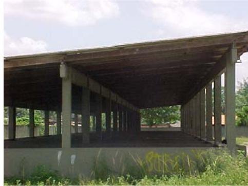
Fotografia 14 – Leitos de secagem de lodo (ETE's 2 e 3 – Coqueiro).
