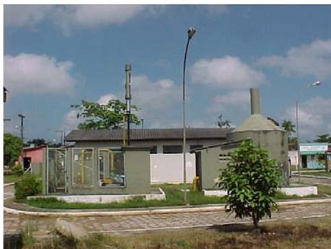
Fotografia 12 – Reator biológico (biogás) e queimador de biogás da ETE Sideral.
