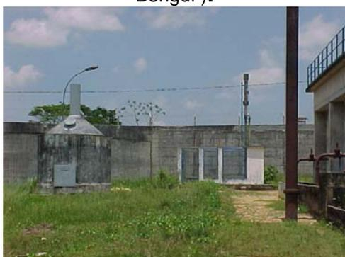
Fotografia 23 – Reator biológico (biogás) e queimador de biogás (ETE 5 – Benguí ).
