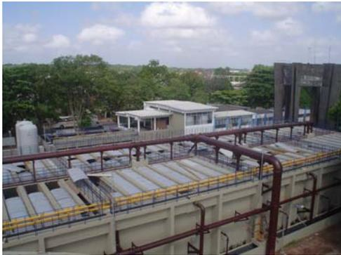
Fotografia 7 – Reatores UASB – ETE Tavares Bastos.
