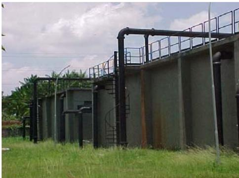
Fotografia 15 – Reatores UASB (ETE's 2 e 3 – Coqueiro).
