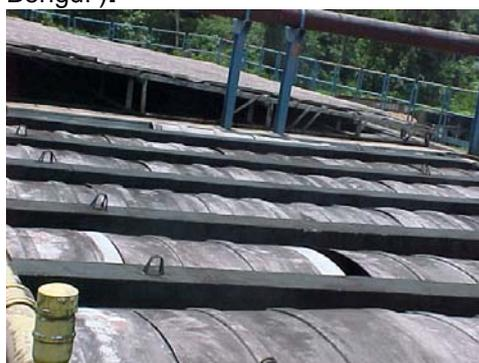
Fotografia 24 – Vista superior reator UASB (ETE 5 – Benguí ).
