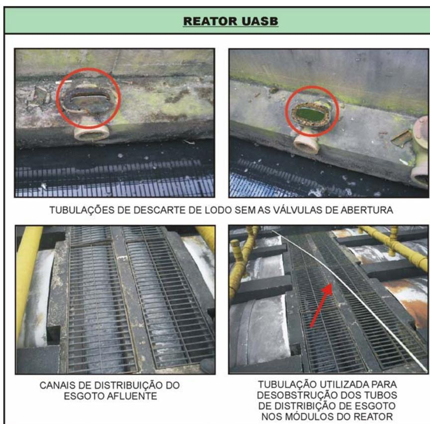
Figura 17 – ETE Sideral (Reator Anaeróbio – UASB, dificuldades de operação).
